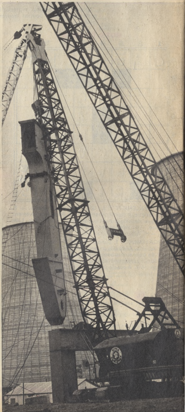
Une vue générale du complexe sidérurgique de Dunkerque. On peut voir un haut fourneau. Ci-contre, une grue pose un gigantesque élément de charpente.
